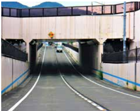
アンダーパスには冠水の際の水深の表示ラインがある道路もある
